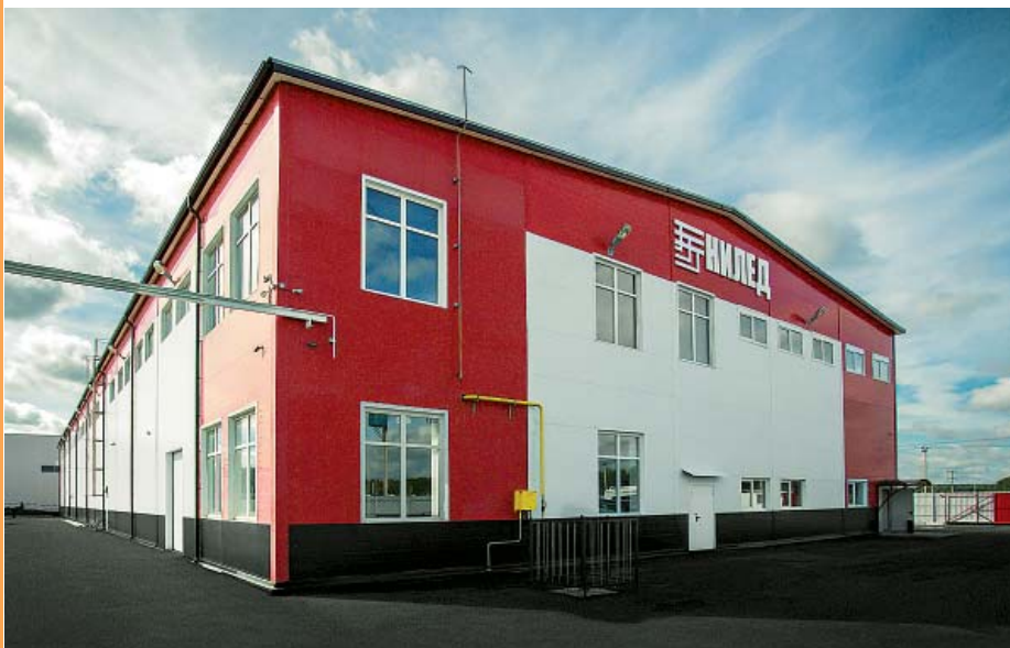
Производственно-складской комплекс компании «НИЛЕД»
